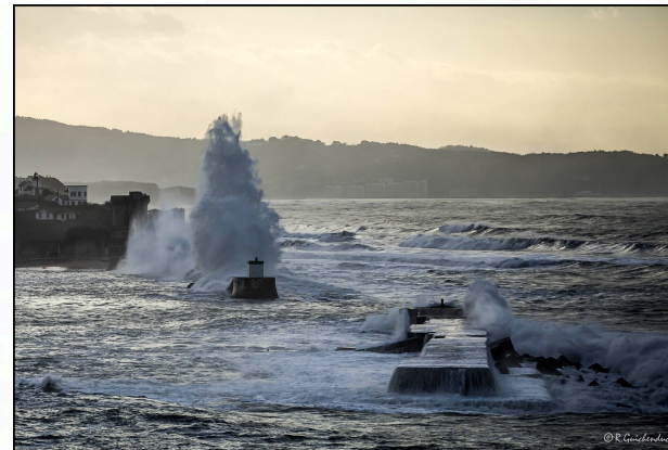
Ouvrages de défense
