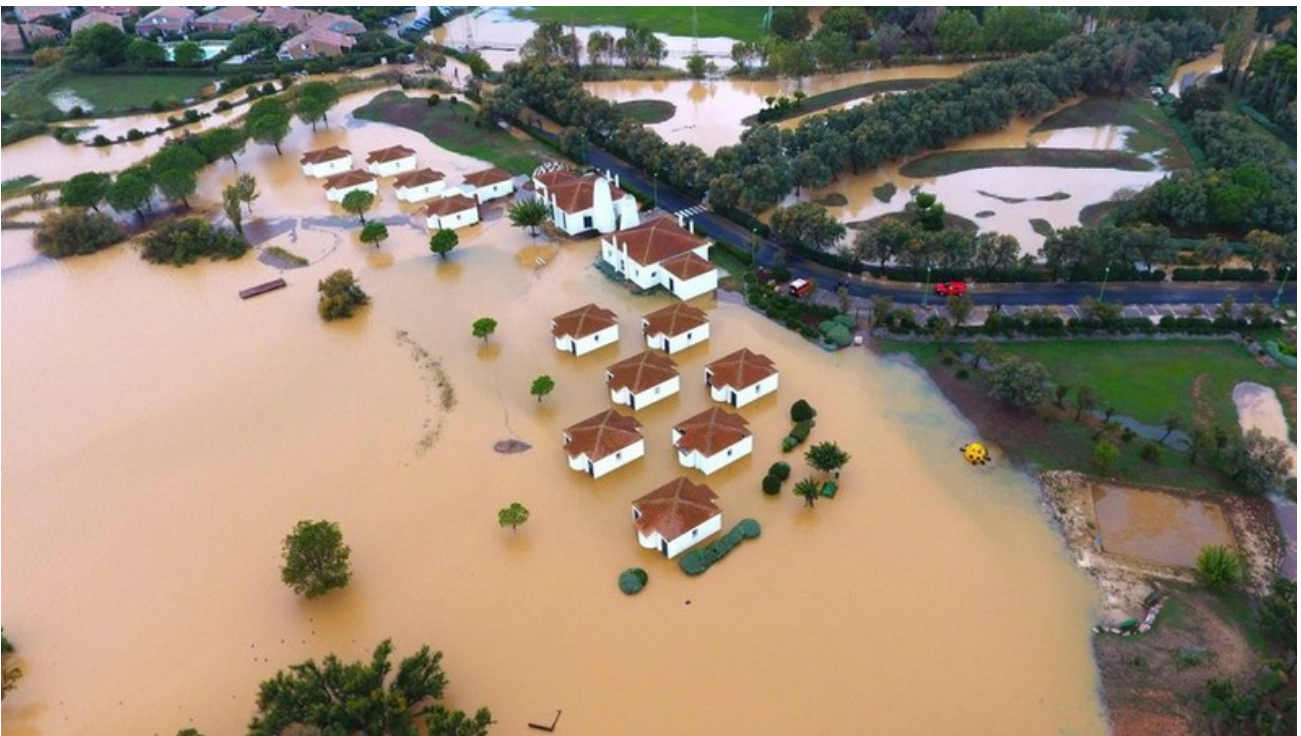
Bungalows communaux les pieds dans l'eau
