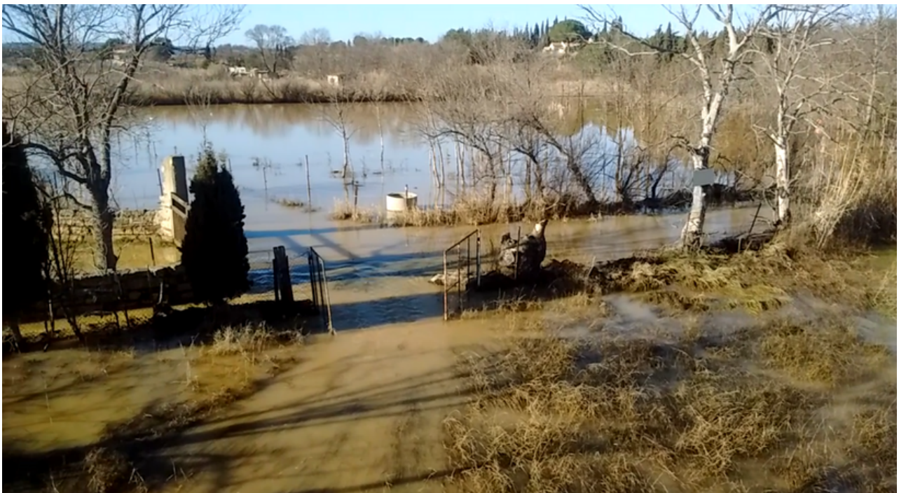
Débordement du Pallas en rive gauche en amont de la D613
