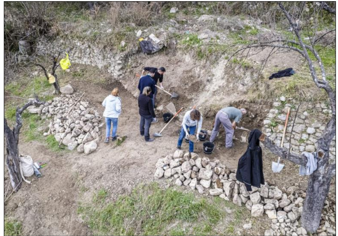
Remise en état de restanque
